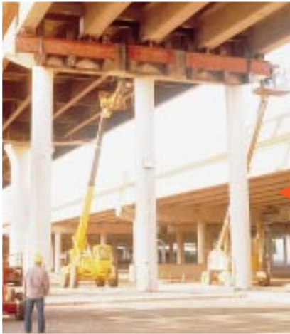
Durch den Hub und Druck von Power Team Zylindern wird ein Brückenpfeiler gerade ausgerichtet.
