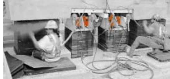
Feststellung hält Last ohne hydraulischen Druck.
