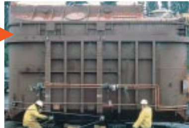
Leichte Aluminium-Zylinder helfen beim Anheben schwerer Elektrotransformatoren
