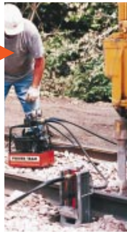
Das Anheben des Herzstücks ist Alltagsarbeit für die Power Team Schienenheber.
