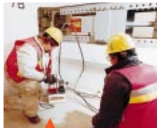
Bei einer Schwimmbrücke werden 52 Hohlkolbenzylinder zum Einstellen von Ankerseilen eingesetzt.
