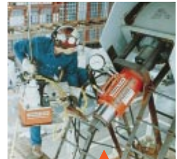
Mit Hohlkolbenzylindern wird das Dachkabel in einem Hängedach gespannt.
