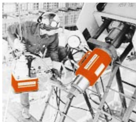
Hohlkolbenzylinder werden zum Spannen von Turmkabeln in einem Hängedach verwendet.
